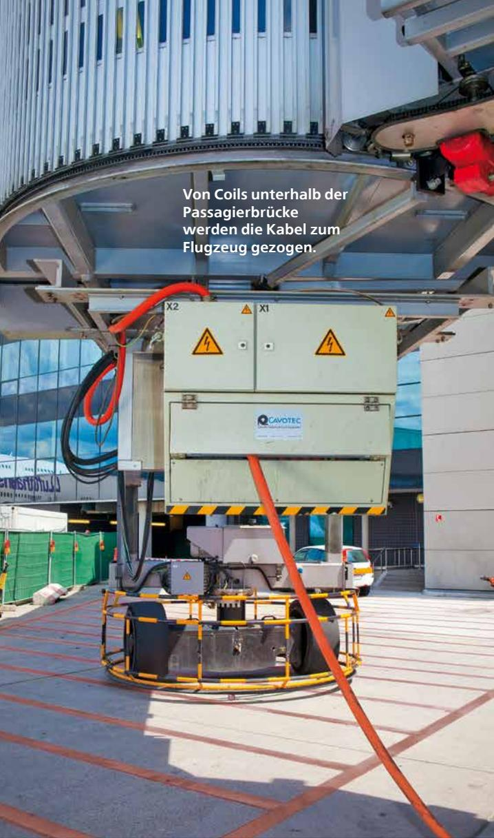
Von Coils unterhalb der Passagierbrücke werden die Kabel zum Flugzeug gezogen.
